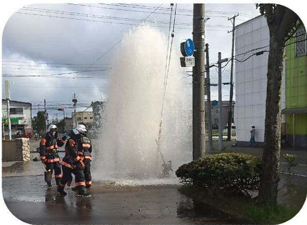
漏水が発生した水道管 (イメージ)
