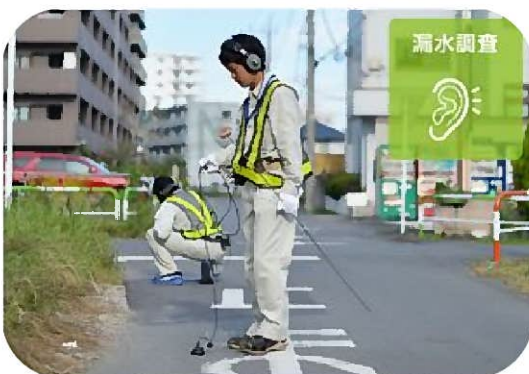
漏水探知機による調査
