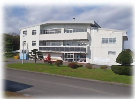
老朽化が進む高丘浄水場管理棟
