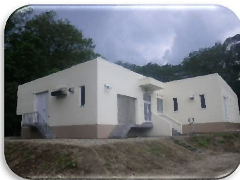
勇振ポンプ場
