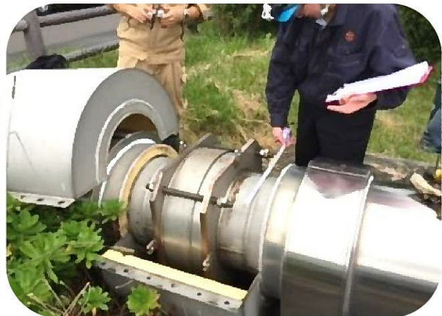
管路の点検作業の様子
