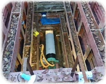
配水本管改良工事
